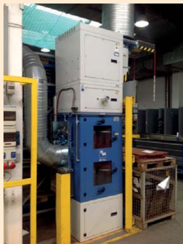
Automatische Lösung mit Hilfe eines Sprengschlauches
