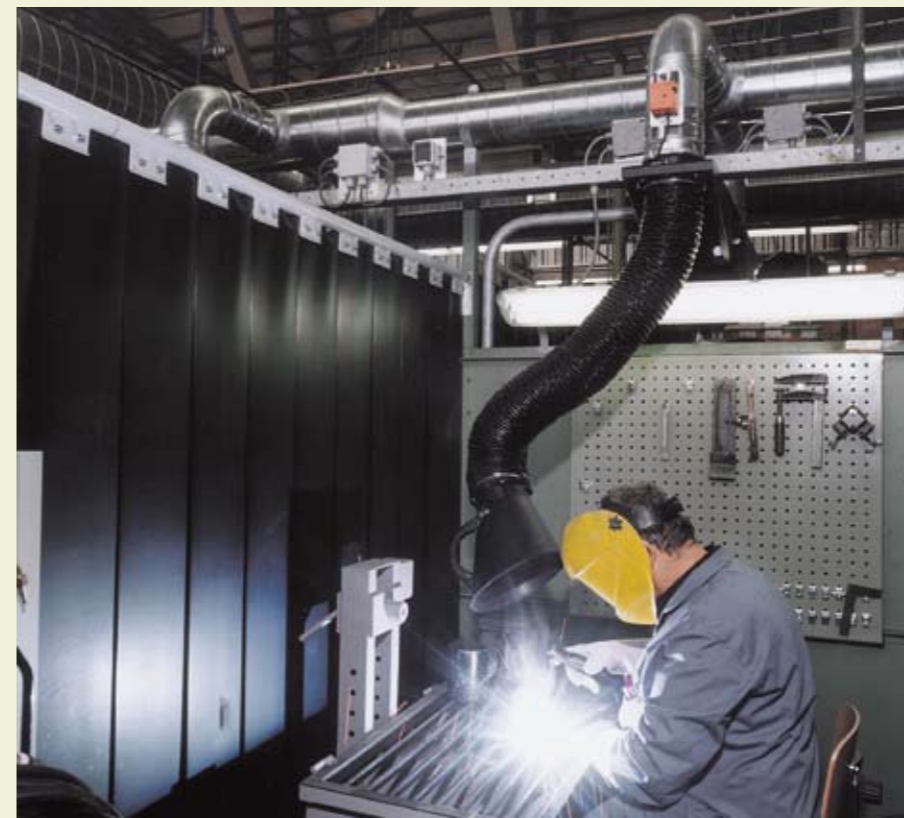
Przykład zastosowania: ramię teleskopowe w kabinie spawalniczej
