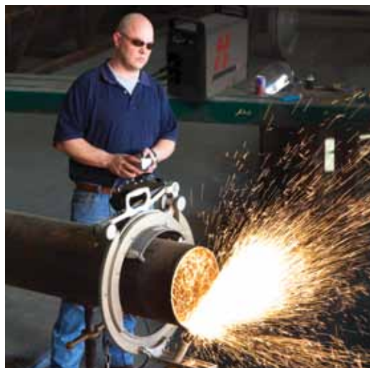
Ukosowanie i cięcie rur
