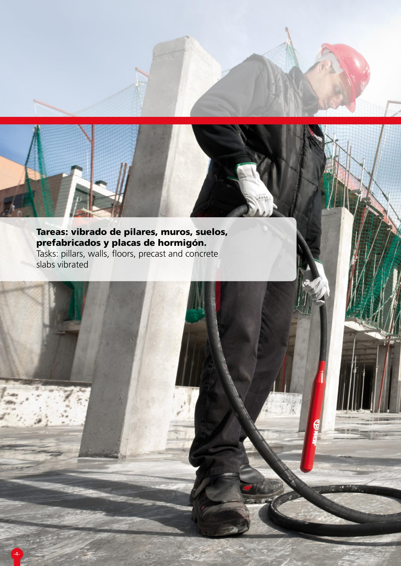
**Tareas: vibrado de pilares, muros, suelos, prefabricados y placas de hormigón.**
