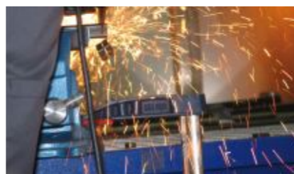
Cięcie profili zamkniętych
