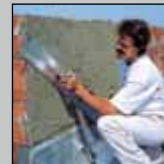
Typ HAK: Wygładzanie powierzchni obrzutki.
