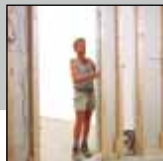
Typ AL 2L: Kontrolowanie słupa ściany.
